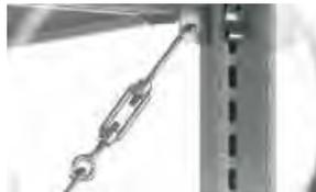
Diagonalstreben mit Spannschlössern stabilisieren die Regale in Längsrichtung, 2 Stück im Grundfeld, 1 Stück in jedem Anbaufeld.
