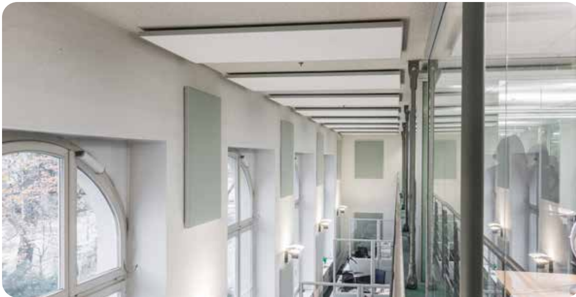
Von oben links nach rechts: Deckenabsorber mit individueller Anbindung an die Tragprofile der Industriedecke, abgehängt zwischen Beleuchtungsebenen und Systemdecke, in Direktmontage mit Konstruktionsabstand
